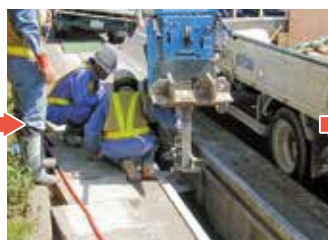
② レールを敷き、レベルカッターをセットする
