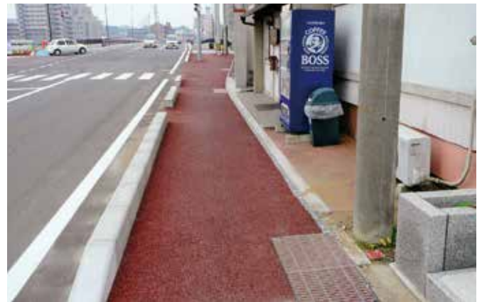
■宮城県仙台市泉区七北田橋付近
