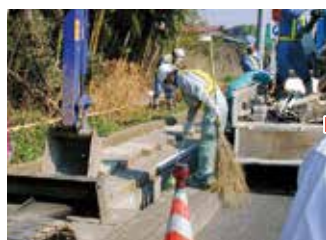
① 蓋を取外して清掃する
