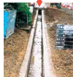
⑤ 切断完了
