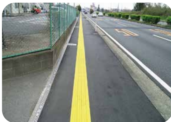
福島県須賀川市 国道4号
