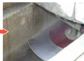
④ 切断状況
