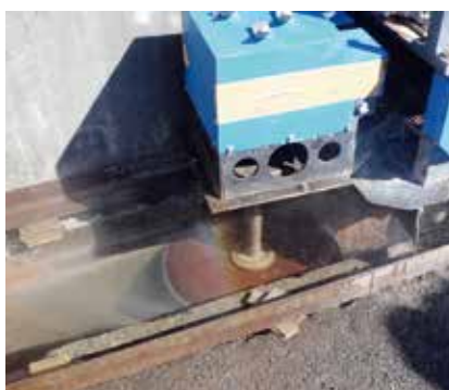
レベルカッター切断
