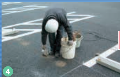
4 モルタル注入 穴にモルタルを注入します。
