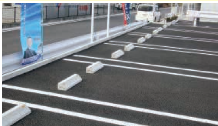
TA-100の施工状況
