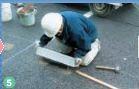
5 据付 穴にアンカーを合わせ据付ます。
