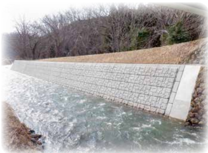
発注者：置賜総合支庁 現場名：令和元年度屋代川河川災害復旧工事
