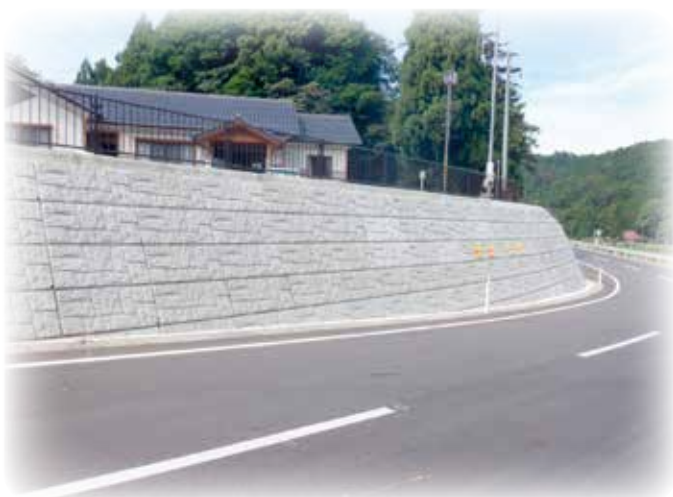
発注者：庄内総合支庁 現場名：令和2年度 田沢下新田線
