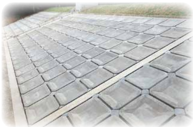
発注者：置賜総合支庁 現場名：水頭地区地域ため池総合整備事業第3工事
